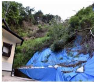
豪雨の度に土砂崩れが多発
