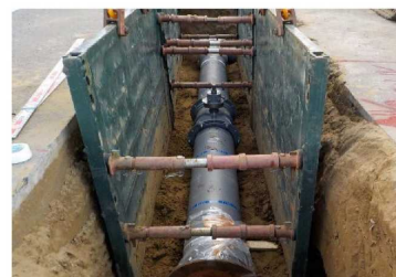
水道管路の耐震化
