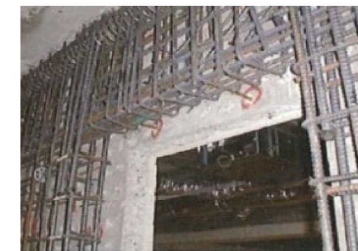
下水処理場の耐震化
