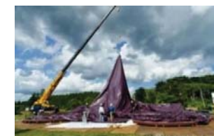
設置中の様子
