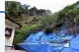
豪雨の度に 土砂崩れが多発
