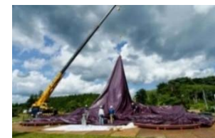
設置中の様子
