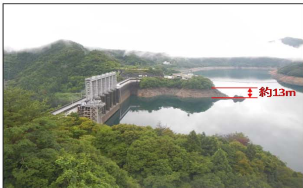
洪水前の早明浦ダム(貯水率59.5%) (平成26年7月7日9時撮影)
