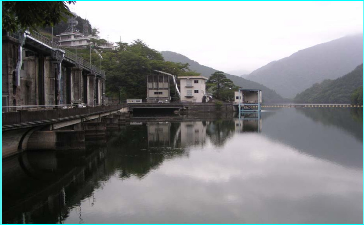
柳瀬ダム（銅山川）満水時 平成19年8月2日時点
