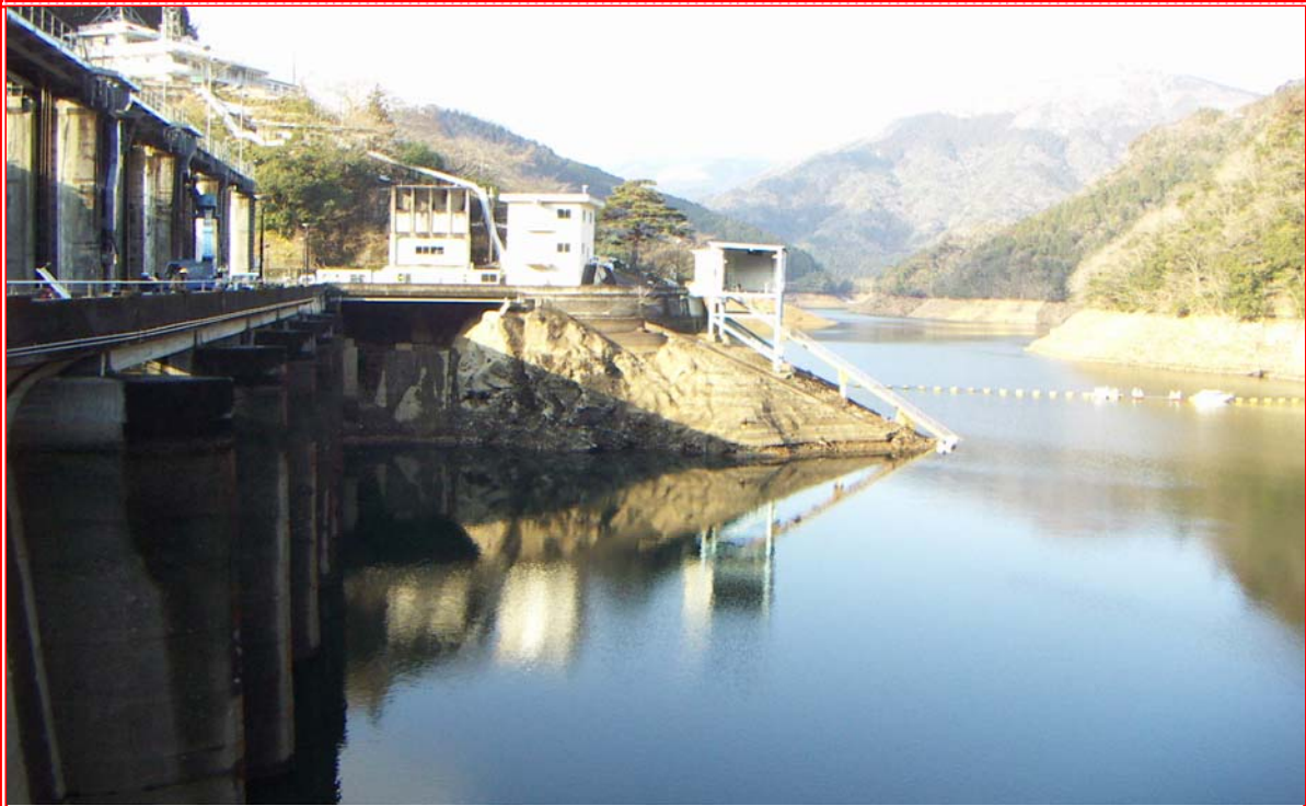
柳瀬ダム（銅山川） 平成20年1月30日時点
