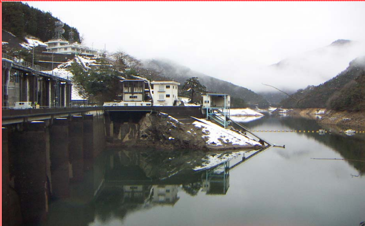
柳瀬ダム（銅山川） 平成20年1月23日時点
