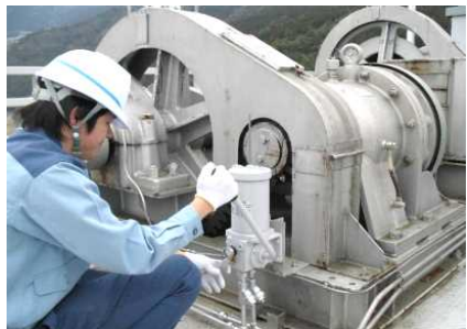
ゲート放流前の機械設備点検状況
