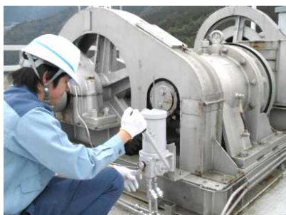
ゲート放流前の機械設備点検状況
