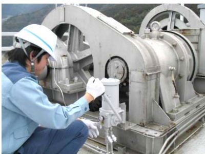
ゲート放流前の機械設備点検状況
