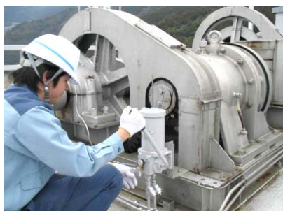
ゲート放流前の機械設備点検状況
