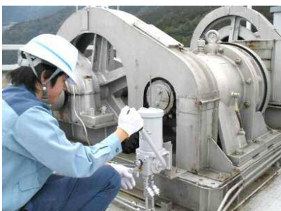
ゲート放流前の機械設備点検状況
