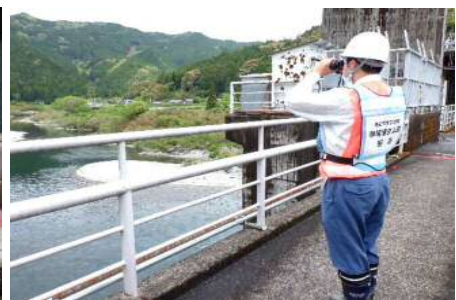
ダム下流河川の巡視状況
