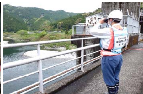
ダム下流河川の巡視状況
