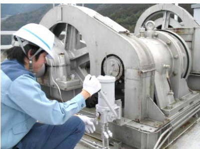
ゲート放流前の機械設備点検状況
