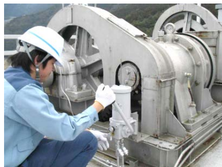
ゲート放流前の機械設備点検状
