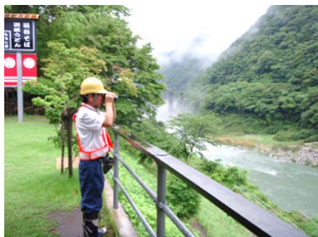
ダム下流河川の巡視状況
