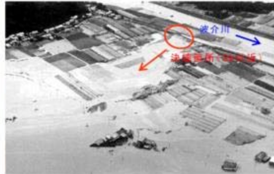
用石地区（本川右岸3k付近）
