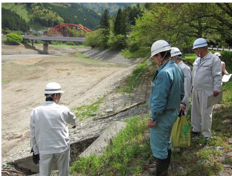
金砂湖畔公園点検状況
