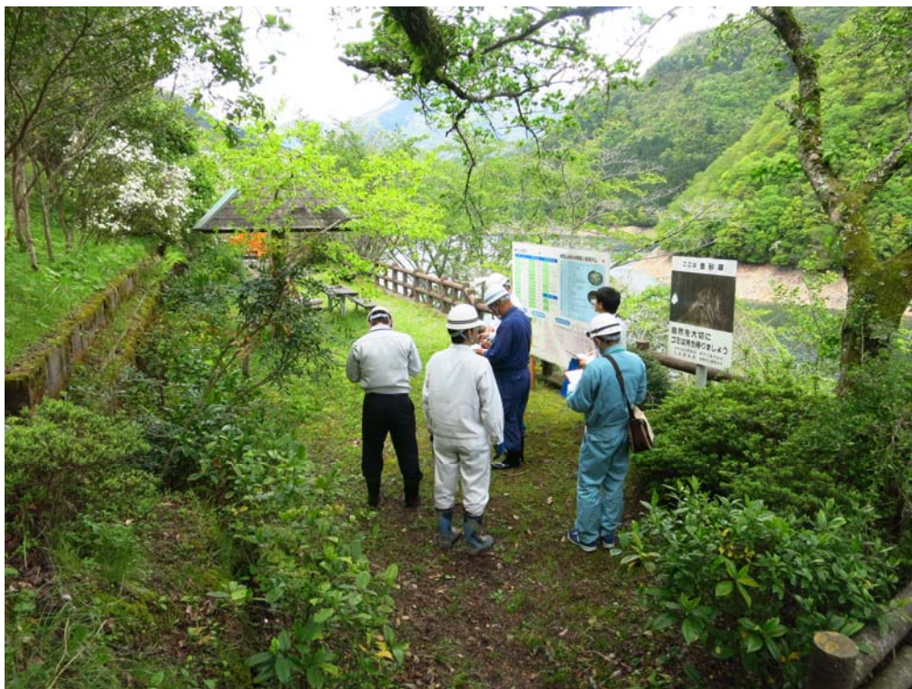
柳瀬ダム周辺点検状況
