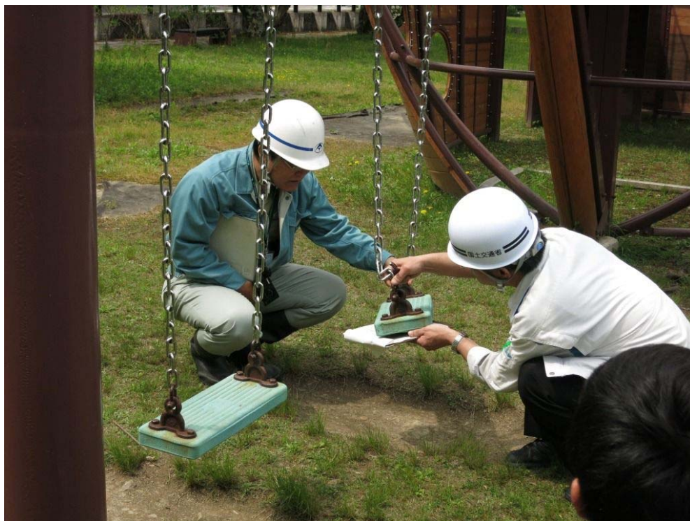
金砂湖畔公園点検状況
