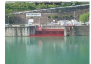
北岸用水取水口
