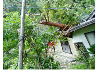
大豊町佐賀山地すべり (平成16年)
