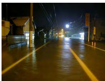
平成17年洪水 いの町幸町地区
