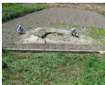
平成17年洪水 土佐市用石地区漏水
