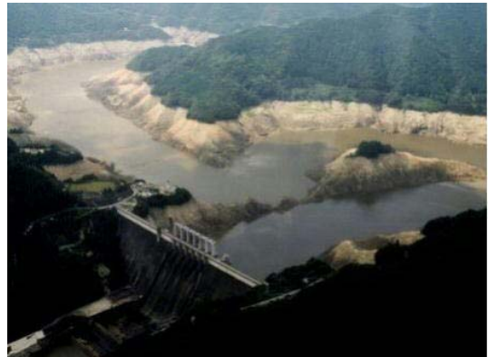
濁水発生状況(平成17年8月)
