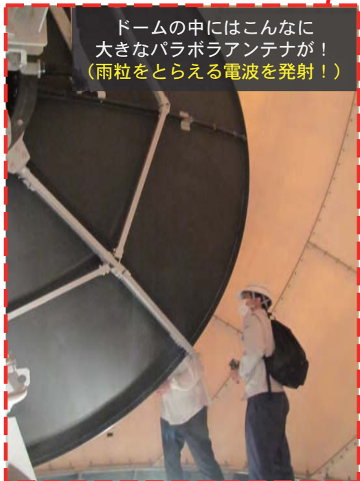
レーダ制御室 パラボラアンテナを動かす重要な部分
