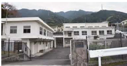
銅山川第一発電所の概観の様子
