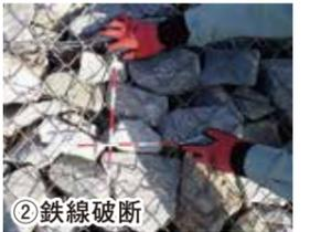
洪水の流れの速い箇所転石等の衝突により、護岸の亀裂、鉄線破断が発生。
