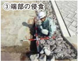
護岸と土堤の粗度係数の違いにより、護岸端部で流速が速くなり、堤体の侵食が発生。
