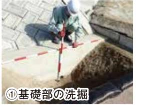
護岸基礎が洗掘を受け沈下、傾倒して発生した目地開き等から土砂が吸い出され、背面空洞や陥没、不陸等が複合的に発生。
