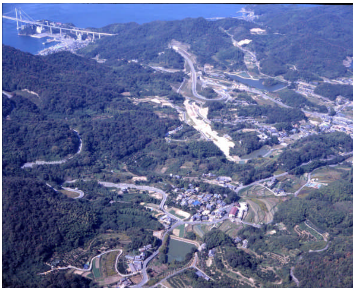
写真 - 2 工事状況写真
