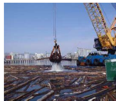
写真－1 作業船による漂流物除去
