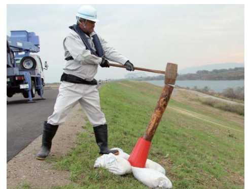
写真－1 一人でできる杭打ち
