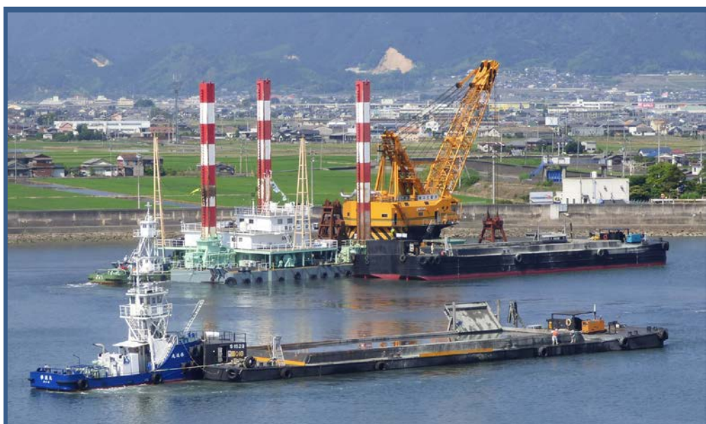
東予港中央地区複合一貫輸送ターミナル整備事業浚渫作業
