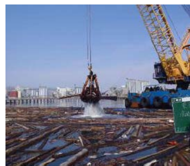
写真－1 作業船による漂流物除去
