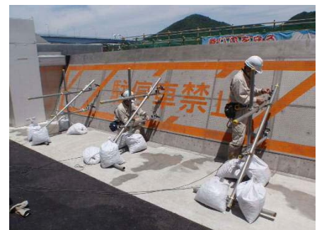
写真-2 変位計設置状況
