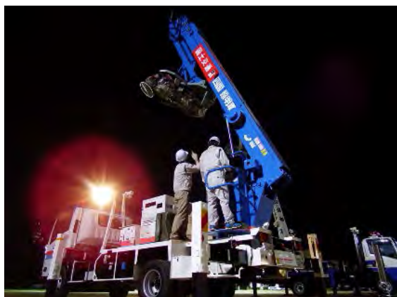
写真－6 照明車ブーム操作状況
