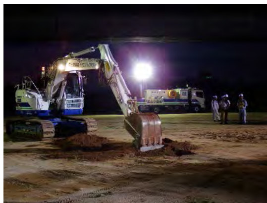
写真－7 遠隔操縦式バックホウ操作状況
