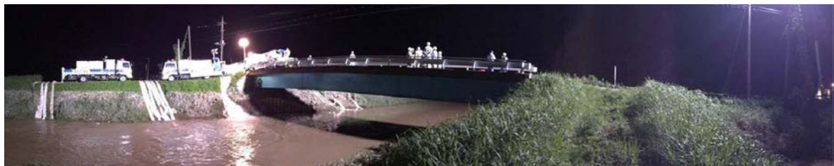
写真－1 24時間体制の排水活動状況（排水ポンプ車・照明車）
