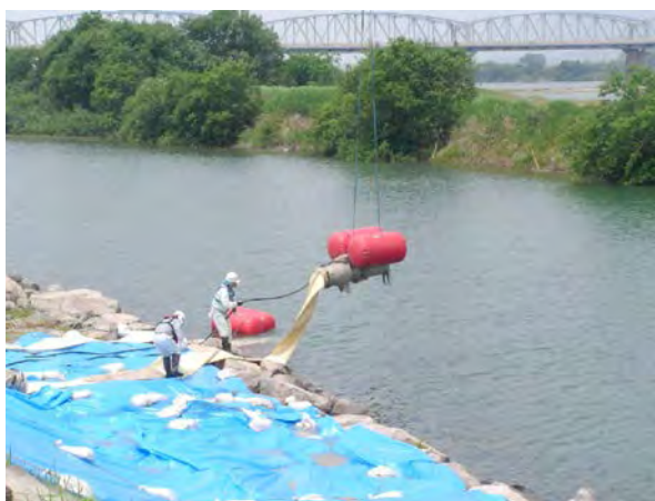
写真-3 据付状況（クレーン）
