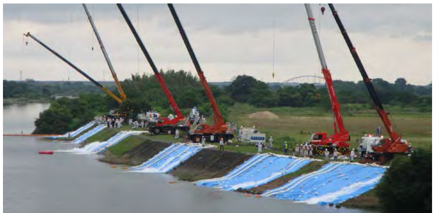
写真－1 「排水ポンプ車訓練」 全景写真
