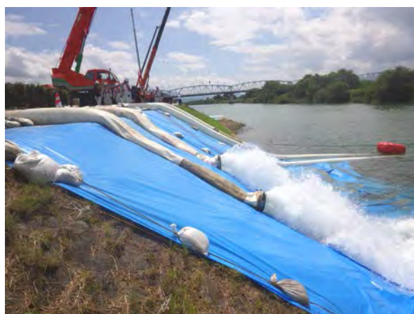
写真-2 排水状況
