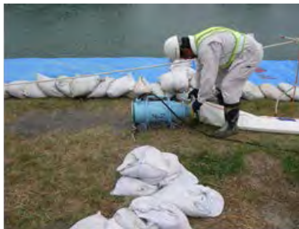
写真-4 据付状況（人力）
