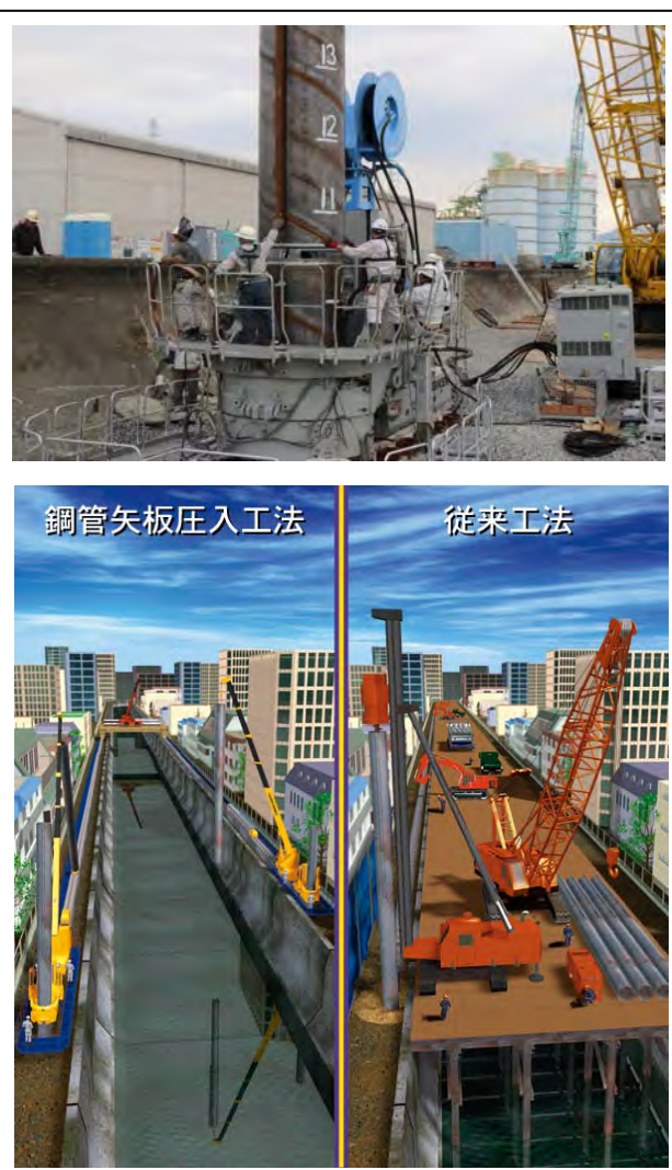
図 鋼管矢板圧入工法（新技術）
