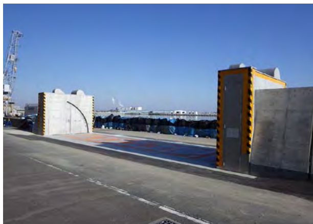
写真 陸上設置型フラップゲート式防潮堤（左：通常時、右：起伏時）（那賀川）
