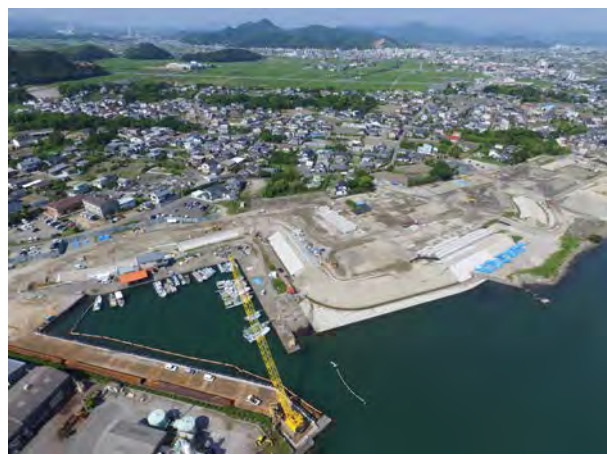
写真 那賀川の工事状況（阿南市黒津地地区）
