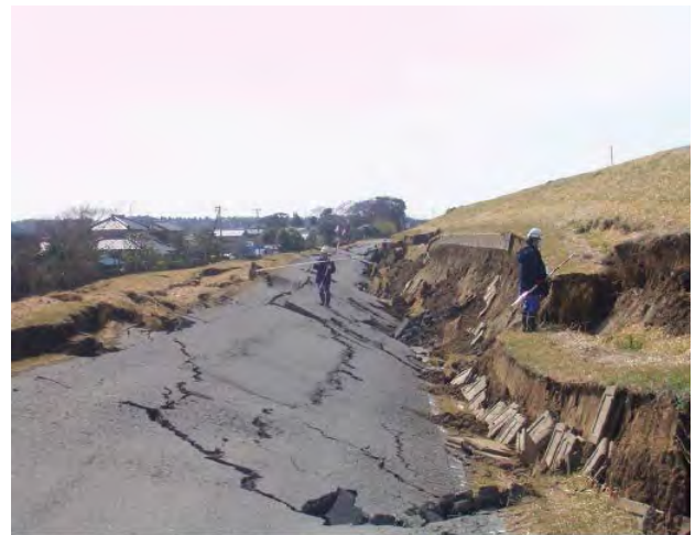
写真 堤防の被災状況（左：鳴瀬川、右：利根川）
