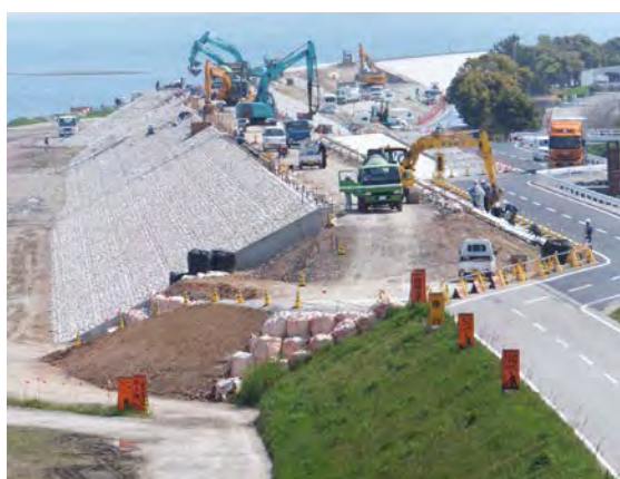
図 河川堤防の工事状況（那賀川）
