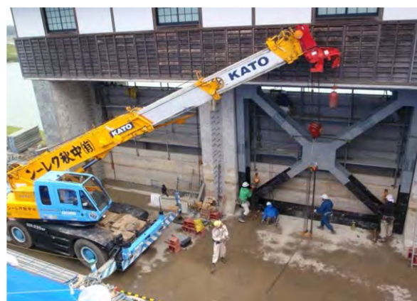
図 樋門の耐震化 工事状況（四万十川・実崎樋門）
