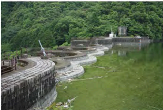
写真-1 貯水池側からみた豊稔池ダム
