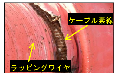
写真-2 メインケーブル損傷状況
