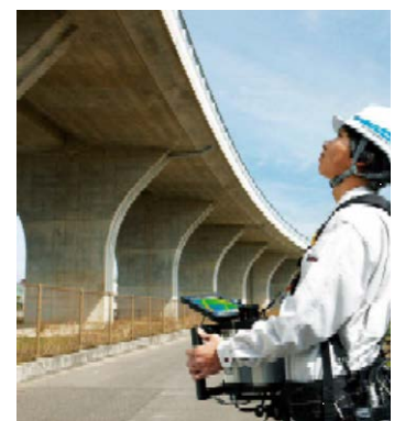
写真-2 赤外線を用いた 損傷箇所計測機 (写真提供：西日本高速道路エン 지니어リング四国(株))
