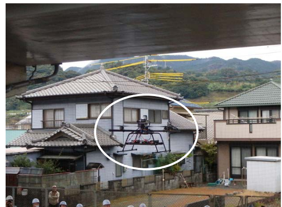
写真-1 マルチコプターを用いた 損傷計測機
