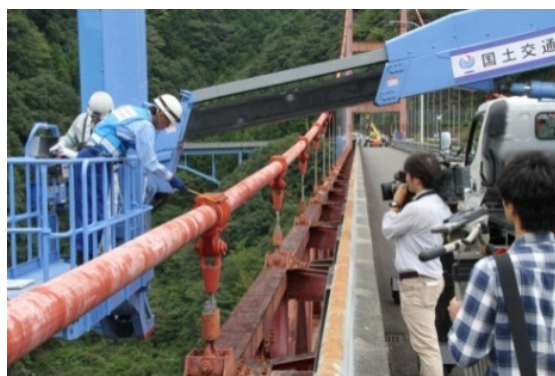
写真-3 直轄診断の実施状況(大渡ダム大橋)
