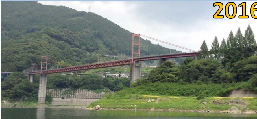
「大渡ダム大橋(高知県仁淀川町)」
