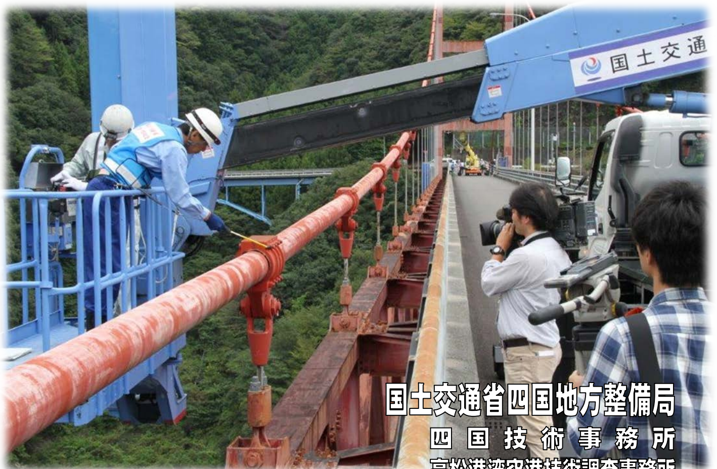
直轄診断「大渡ダム大橋」
