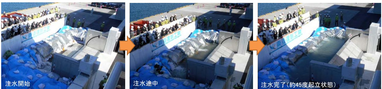
写真-2 フラップゲート式陸閘の起立状況
