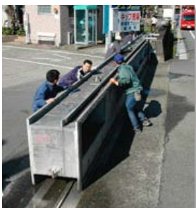
写真-1 通常の陸閘
