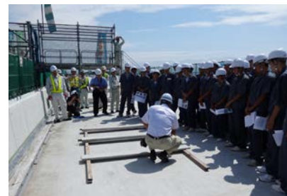
(仮称) 松山中央公園第2橋工事現場 (松山河川国道事務所職員による説明)
