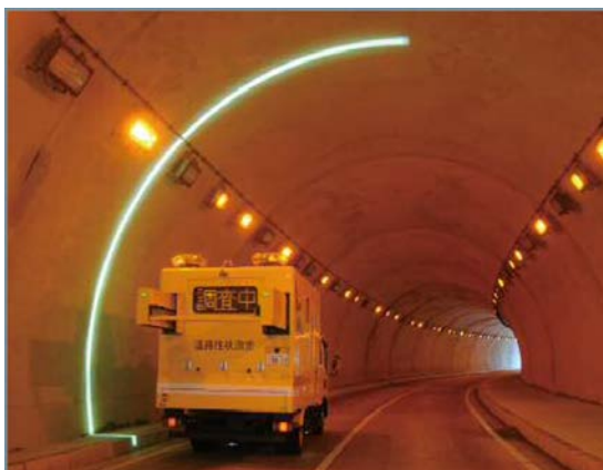
写真－4 トンネル覆工面の調査車両 (写真提供：西日本高速道路エンジニアリング四国(株))
