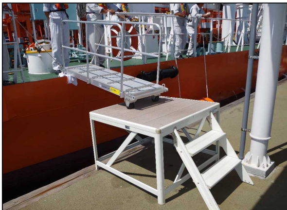
写真－3 昇降設備の設置
