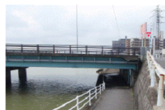
アンダーパスの部分を調査
