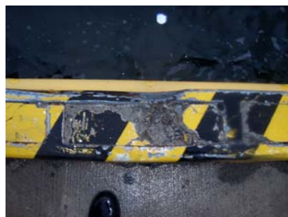
車止め損傷
