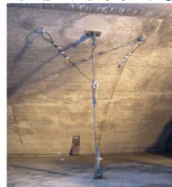
フェールセーフワイヤーによる補強状況
