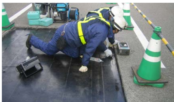
写真-2 鋼床版上面からの調査状況
