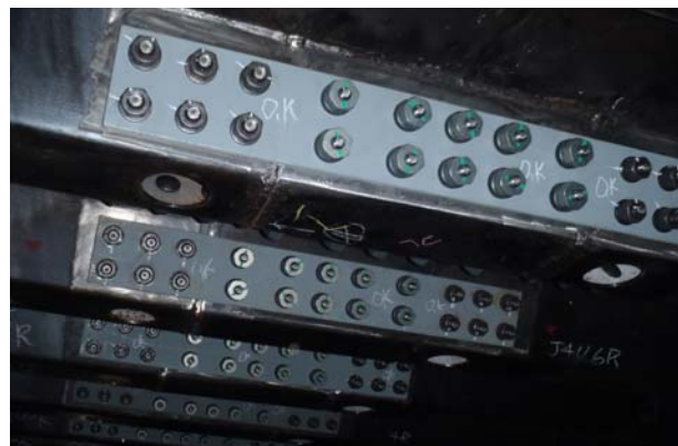
写真-5 あて板補強完了状況
