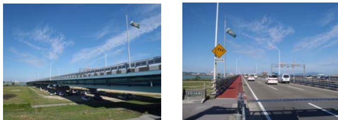
写真-1 吉野川大橋（下り）
