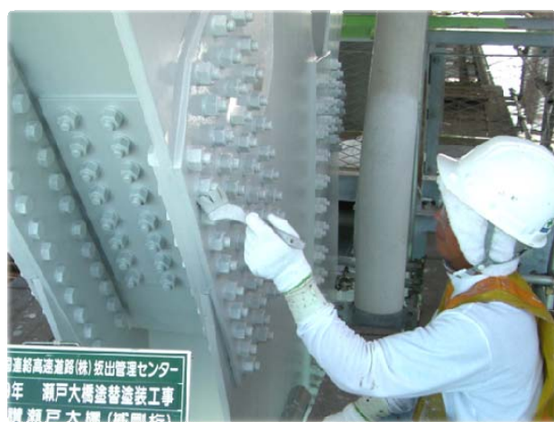
写真-3 上塗りの施工状況
