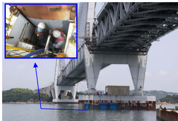
写真-6 ドライボックスによる施工
