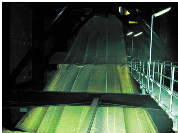
写真-5 スプレー室内のテント設置状況
