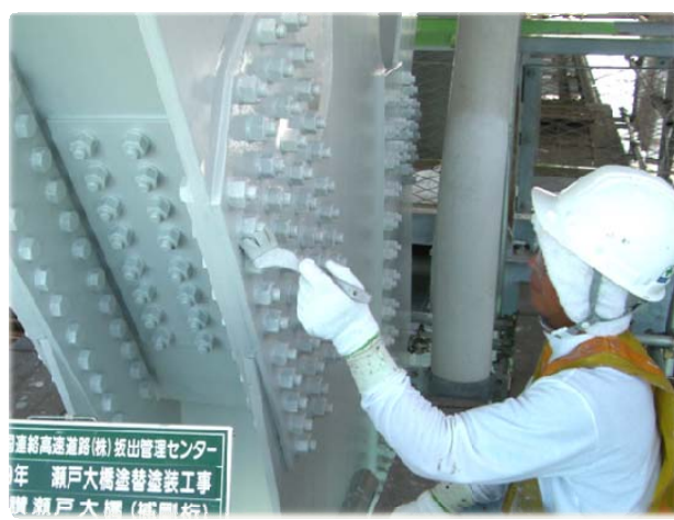
写真-3 上塗りの施工状況
