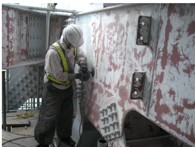
写真-2 素地調整の状況
