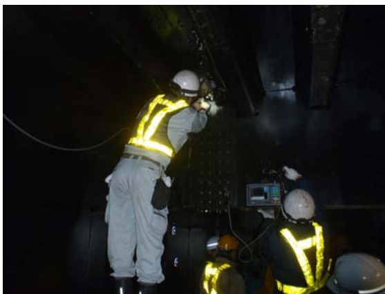
写真-3 鋼床版下面（箱桁内部）からの調査状況
