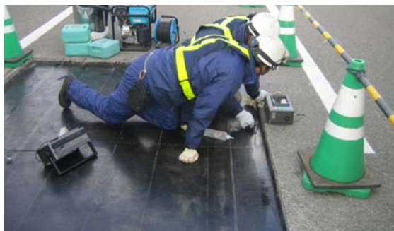
写真-2 鋼床版上面からの調査状況
