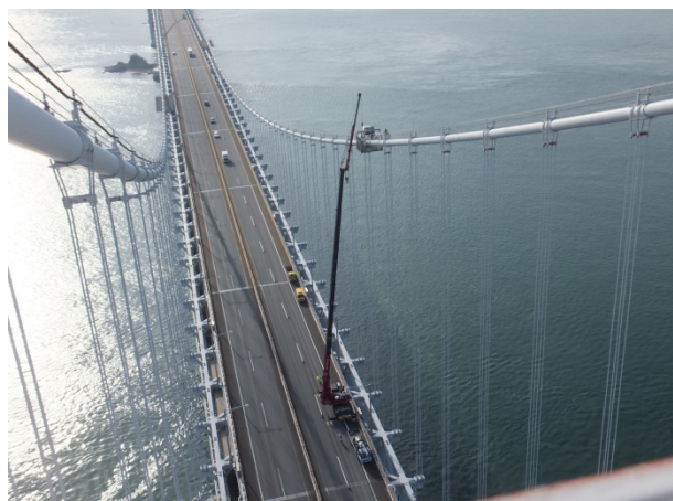
写真-4 送気バンドの増設状況
