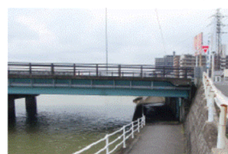
アンダーパスの部分を調査
