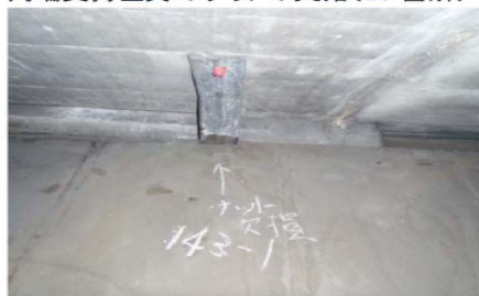
吊金具定着部のコンクリートのうき(19箇所)
