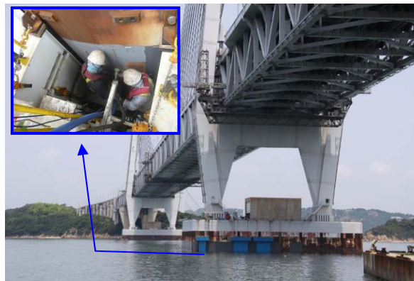
写真-6 ドライボックスによる施工
