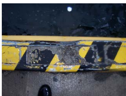
車止め損傷
