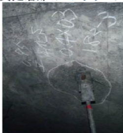
吊金具定着部のコンクリートのうき(19箇所)
