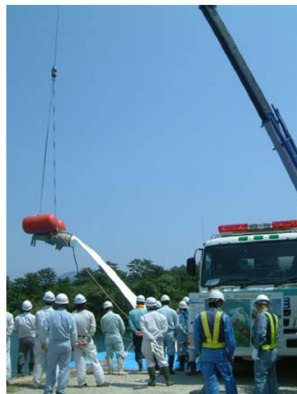
写真一 排水ポンプ吊上げ状況
