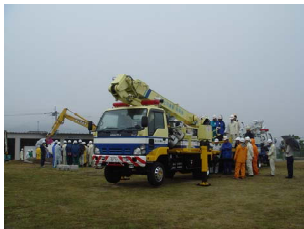
写真一 災害対策用機械の訓練状況
