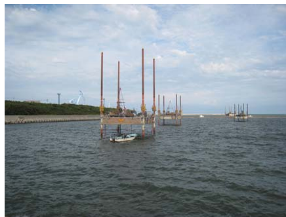
写真－3 海上でのボーリング調査状況 (スパッド台船)
