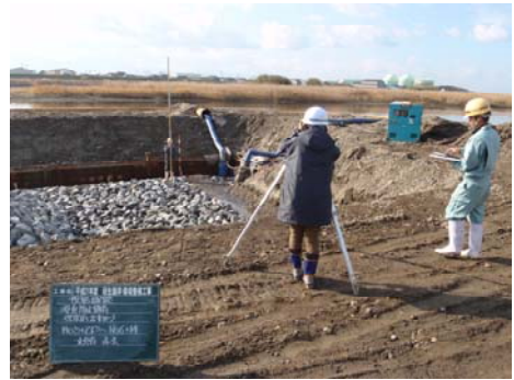
写真－2 工事立会状況
