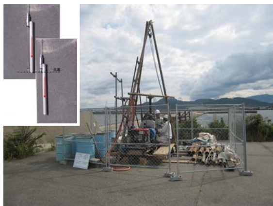
写真－2 陸上でのボーリング調査状況
