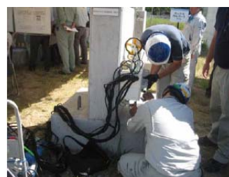
レーダーによる測定状況
