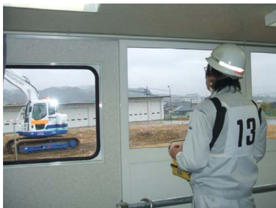
写真一 遠隔操縦訓練の状況
