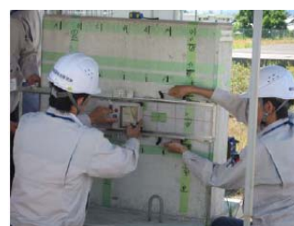
鉄筋破断測定中
