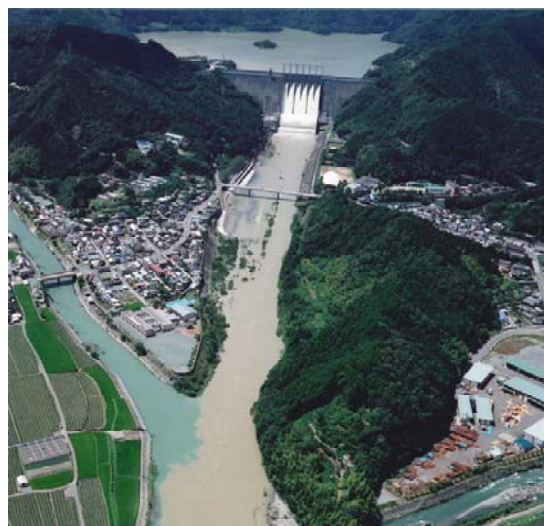
洪水後の早明浦ダムからの濁水放流状況 (平成16年8月)
