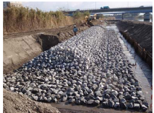
写真－1 垣生再生護岸不可視部分
