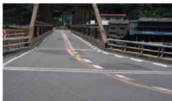
(施工前の床版の状況写真)
