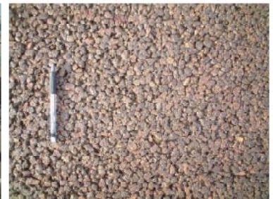
写真-4 舗装表面(試験施工直後)
