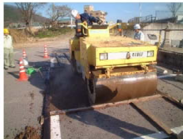
写真-3 試験施工状況
