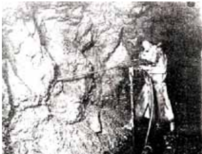
写真 - 4 銅山川疎水隧道工事
