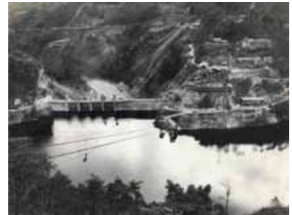
写真 - 6 湛水完了後の柳瀬ダム
